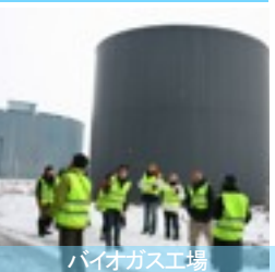
バイオガス工場
